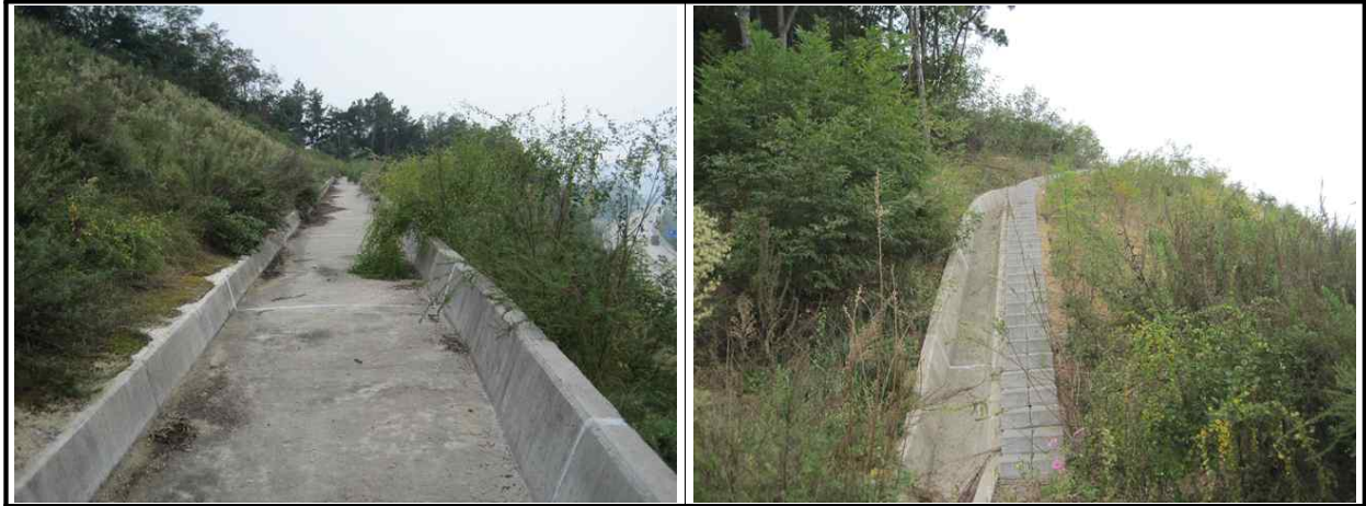
【그림 6.3.3】 배수시설 전경
